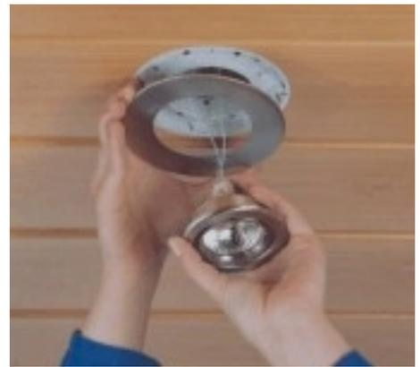
Beim nachträglichen Einbau in Hohldecken, können kleinere Leuchten die **ThermoX**-Gehäuse nicht abdecken. Hier kommt der Abdeckring zum Einsatz.
